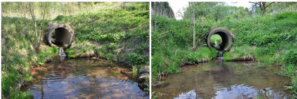
Propustek vodoteče vybudovaný pro přejezd techniky a osob, v různém vegetačním období
